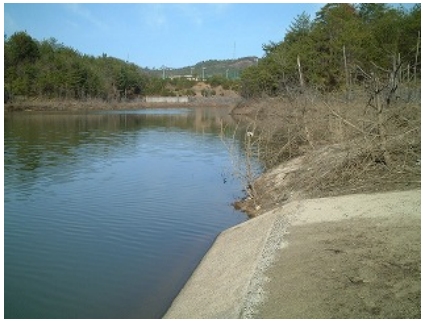
角脇防犯調節池(広大下流池水)
