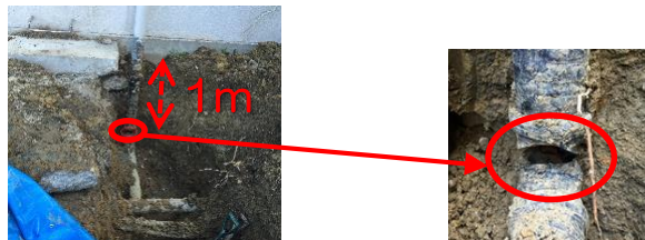
図. RI排水管破断箇所（赤丸）及び拡大図
